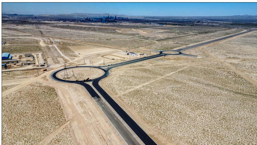
پروژه شبکه معابر داخلی شهرک صنعتی تخصصی گل گهر پیمانکار: شرکت ژيوار توسعه کرد هدف اجرای پروژه: تامین دسترسی داخلی سایت شهرک صنعتی منطقه گل گهر اعتبار پروژه: ۸۰۰ میلیارد ریال مشاور: شرکت طرح کارنو میزان پیشرفت: ۱۵ درصد
