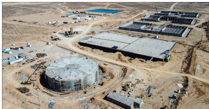
مخزن ۳۰ هزار متر مکعبی سایت آبی پیمانکار: شرکت جهاد نصر بزد تامین امکان انباشت آب مصارف صنعتی سایت‌های منطقه
