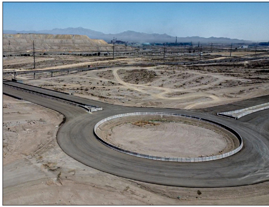
پروژه جاده شماره ۴ اعتبار پروژه: ۳۸۰۰ میلیارد ریال مشاور: شرکت طرح گارنو پیمانکار: شرکت فرحان سازان کرمان هدف اجرای پروژه: محور ارتباطی مختلط بین ناحیه غربی و شرقی منطقه گل گهر میزان پیشرفت: ۸۰ درصد
