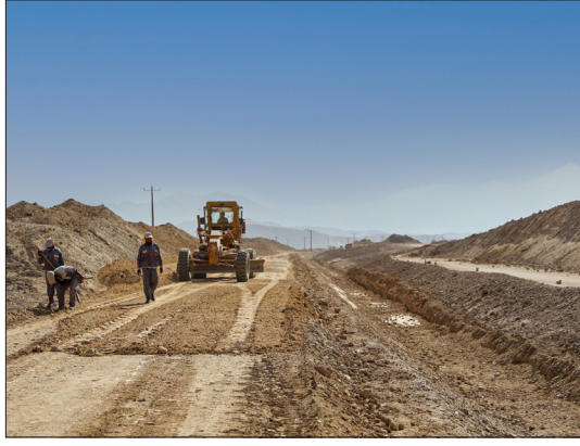
پروژه هدایت آب های سطحی فاز ۴ اعتبار پروژه: ۱۲۰ میلیارد ریال مشاور: شرکت رهنمای شرق راه پیمانکار: شرکت فرحان سازان کرمان و بهیر سیرجان هدف اجرای پروژه: هدایت رواناب های سایت های منطقه به خارج از منطقه گل گهر میزان پیشرفت: ۳۳ درصد
