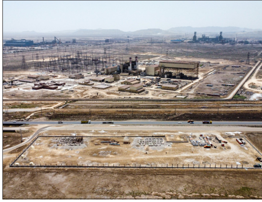
پروژه پاسگاه خیرآباد اعتبار پروژه: ۳۰۰ میلیارد ریال مشاور: شرکت ابنیه نواندیش پیمانکار: شرکت ارسا خاک بی هدف اجرای پروژه: ساماندهی ورودی شماره یک منطقه گل گهر و پیش نیاز احداث پل کل گهر میزان پیشرفت: ۱۵ درصد
