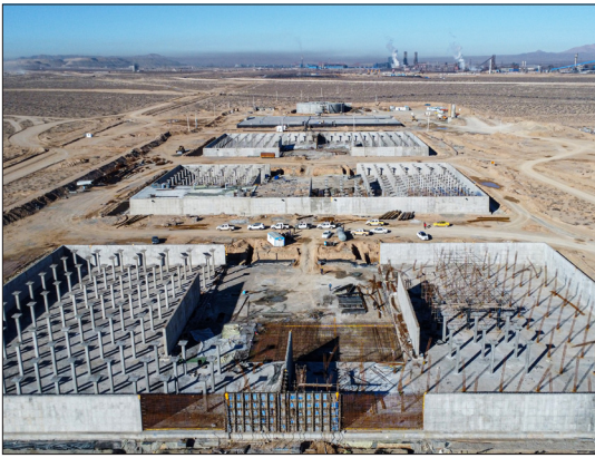
پروژه مخازن ۳۰ هزار مترمکعبی اعتبار پروژه: ۱۰۰۰ میلیارد ریال مشاور: شرکت لار پیمانکار: شرکت جهاد نصر یزد هدف اجرای پروژه: انباشت آب خلیج فارس در سایت آبی منطقه گل گهر جهت مصارف صنعتی میزان پیشرفت: ۶۵ درصد
