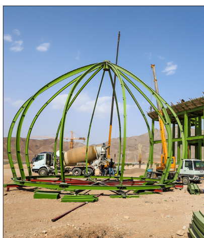
پروژه مسجد سایت گردشگری گهرپارک پیمانکار: شرکت آرمه سازه نوین هدف اجرای پروژه: ساخت مسجد در سایت گردشگری گهرپارک اعتبار پروژه: ۴۰۰ میلیارد ریال مشاور: شرکت ابنیه نواندیش میزان پیشرفت: ۴۶ درصد
