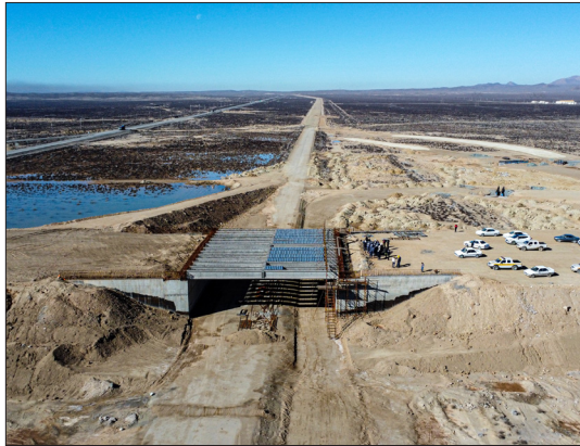
پروژه پل صنعت اعتبار پروژه: ۱۸۰۰ میلیارد ریال مشاور: شرکت رهنمای شرق راه پیمانکار: شرکت آرمان گهر سیرجان هدف اجرای پروژه: تامین ورودی ایمن جاده شماره ۲ منطقه گل گهر از محور سیرجان-شیراز و تامین دسترسی شهرک حمل و نقل
